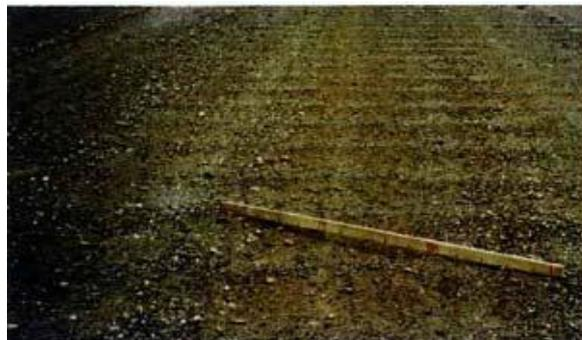
**Figure 1.3** : Tôle ondulée
